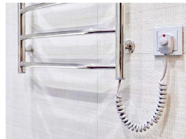
Il est composé d'un fluide caloporteur qui chauffe grâce à une résistance électrique. Ce fluide caloporteur une fois chaud, se déplace dans les nombreux tubes qui composent le sèche-serviette. Dans certains cas, il n'y a pas besoin de fluide caloporteur, c'est le matériau constitutif du radiateur lui-même qui conduit la chaleur.
