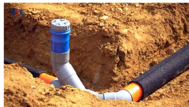
Un tuyau de drainage, installé avec une pente variant entre 3 et 10 mm/m, collecte et évacue l'eau. Le tuyau doit être au minimum avec un diamètre de 100 mm et peut être en PVC perforé, en terre cuite, en béton poreux ou perforé.
