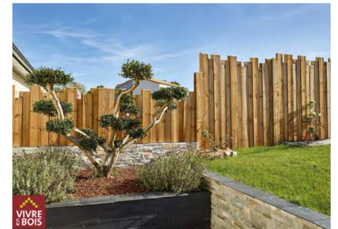
Généralement, ce sont des palissades en bois posées sur des poteaux fixés au sol. Les poteaux doivent alors être correctement ancrés au sol afin d'assurer la bonne tenue de la clôture et donc sa longévité.
